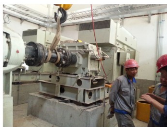
现场指导安装
