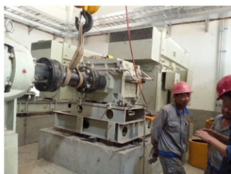
现场指导安装
